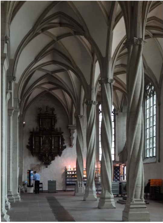
Netzgewölbe im nördlichen Seitenschiff, ruhend auf gewundenen Säulen
