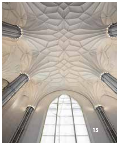
Chorgewölbe im Paulinum (Baustand Januar 2014)
