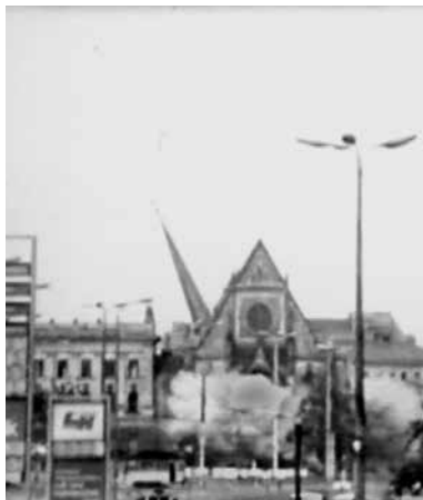
Sprengung am 30. Mai 1968
